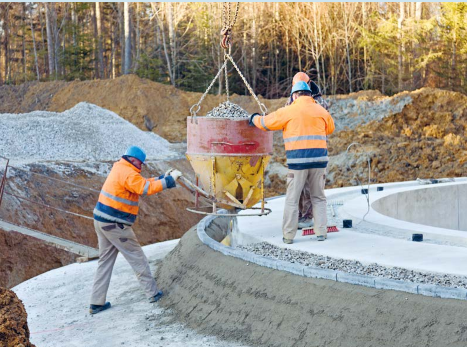
Dank der Windkraft sind zusätzliche Aufträge für heimische Unternehmen sowie neue Wartungsstützpunkte mit 14 festen Serviceteams und 28 Beschäftigten entstanden; ähnlich im PV-Bereich für die etwa 4.400 Anlagen
